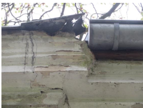
Zdjęcie nr 59. Zniszczony fragment rynny i wylewka przy ścianie cokołu w byłej oranżerii.
