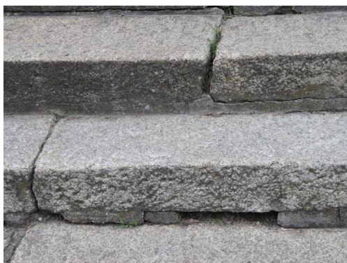
Zdjęcie nr 41, nr 42. Ubytki fugi i brak liniowości stopnie – stopnie frontu.
