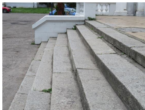
Zdjęcie nr 41, nr 42. Ubytki fugi i brak liniowości stopnie – stopnie frontu.
