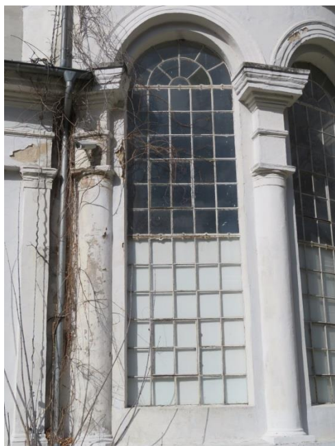
Zdjęcie nr 34. Okno stalowe O22.
