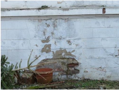
Zdjęcie nr 17. Zamurowanie od zewnątrz.
