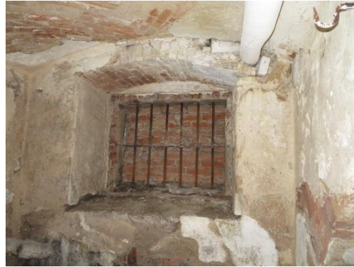
Zdjęcie nr 18. Zamurowanie od wewnątrz.
