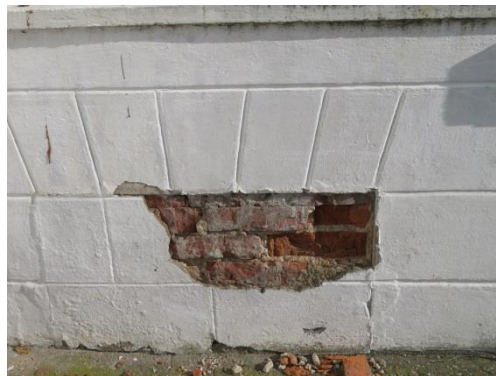
Zdjęcie nr 27. Cokół na zamurowanym oknie piwnicy.
