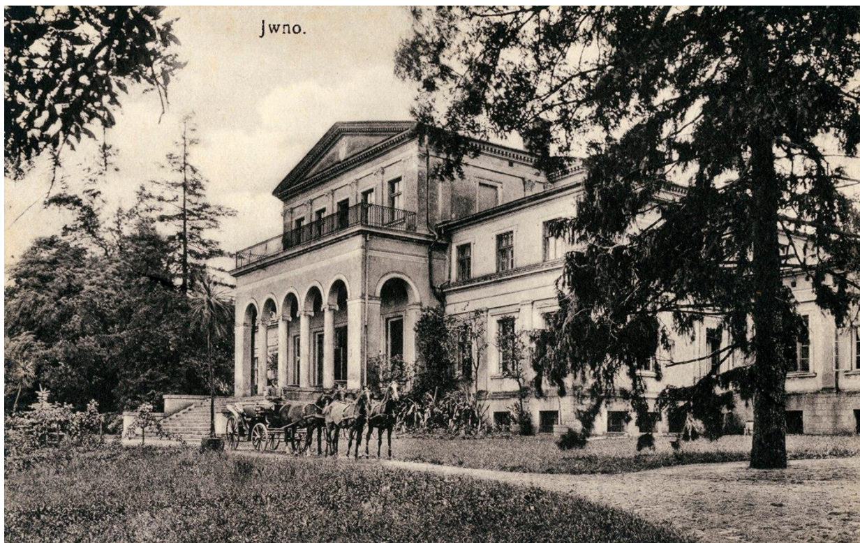
Zdjęcie nr 4. Elewacja ogrodowa – strona północna.
