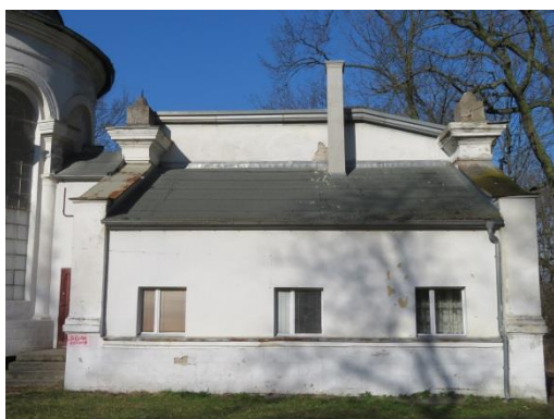
Zdjęcie nr 11. Elewacja południowa.
