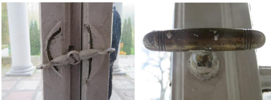
Zdjęcie nr 39. Zamknięcie okna O7.
