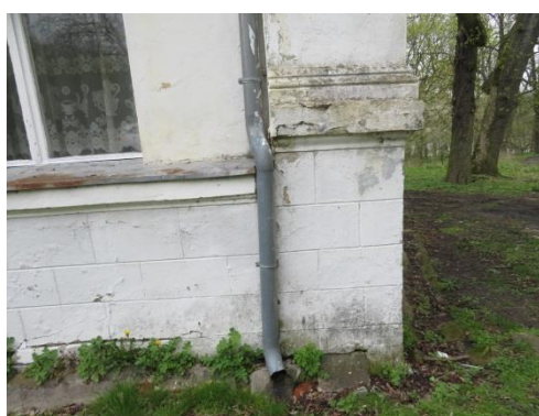
Zdjęcie nr 59. Zniszczony fragment rynny i wylewka przy ścianie cokołu w byłej oranżerii.
